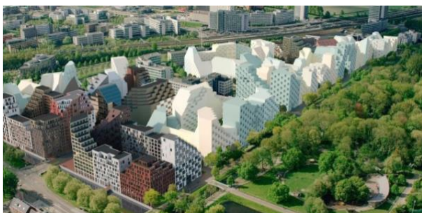
Afbeelding 3.3: Project Hyde Park bij station Hoofddorp. Deze gebiedsontwikkeling heeft een grote schaal en bouwsnelheid (3.800 woningen en 40.000 m 2 commercieel) en bestaat uit gestapelde woningbouw. Hier is gekozen voor een collectief systeem dat wordt ontwikkeld door één exploitant. Per fase van meerdere woongebouwen komt één collectief warmtepompsysteem. In totaal komen er 4 à 5 clusters. Voor het hele gebied wordt een WKO-systeem in combinatie met aquathermie gerealiseerd als bron voor de collectieve warmtepompen.
