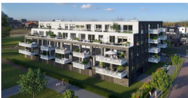
Afbeelding 3.2: Project Anna's Hoeve in Hilversum. Deze ontwikkeling bestaat uit 65 huurwoningen gestapelde woningbouw. Hier is gekozen voor een collectief warmtepompsysteem. Het project is te klein voor een WKO-systeem. Daarom is gekozen voor buitenlucht als bron voor de warmtepompen.
